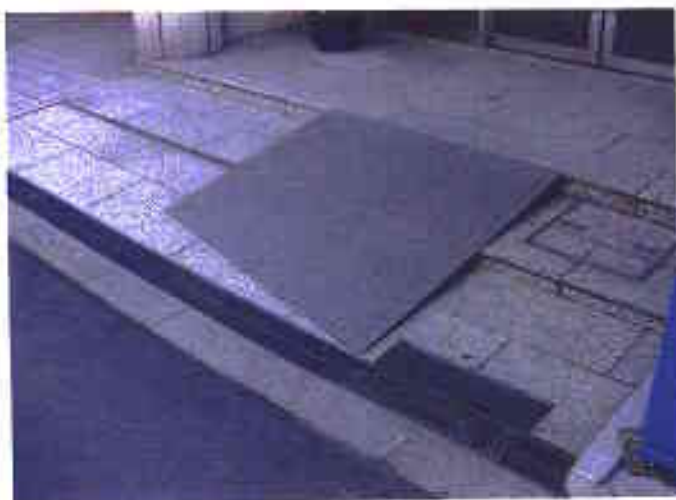
1Fエントランススロープ-02
