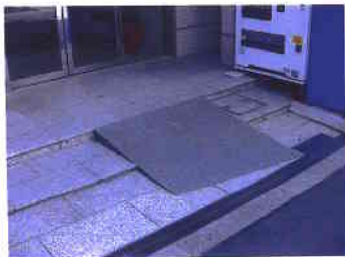
1Fエントランススロープ-01
