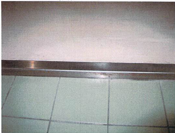
WC入口段差解消 (H30)
